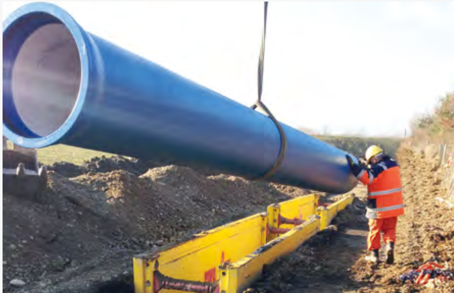
Leichtverbau 600 Einsatz Kanalbau
