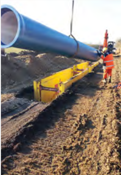
Leichtverbau Einsatz Kanalbau
