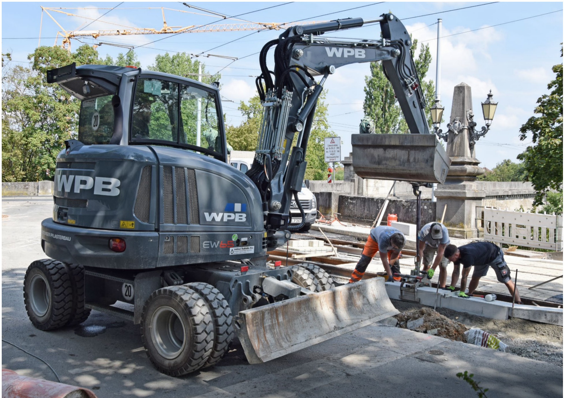
Der Mobilbagger EW65, lackiert in der Firmenfarbe des Unternehmens, beim Einsatz auf einer beengten Baustelle.
