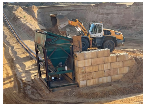
Die neu angeschafften XPower-Radlader werden bei Esser Kies im Kiestagebau eingesetzt.
