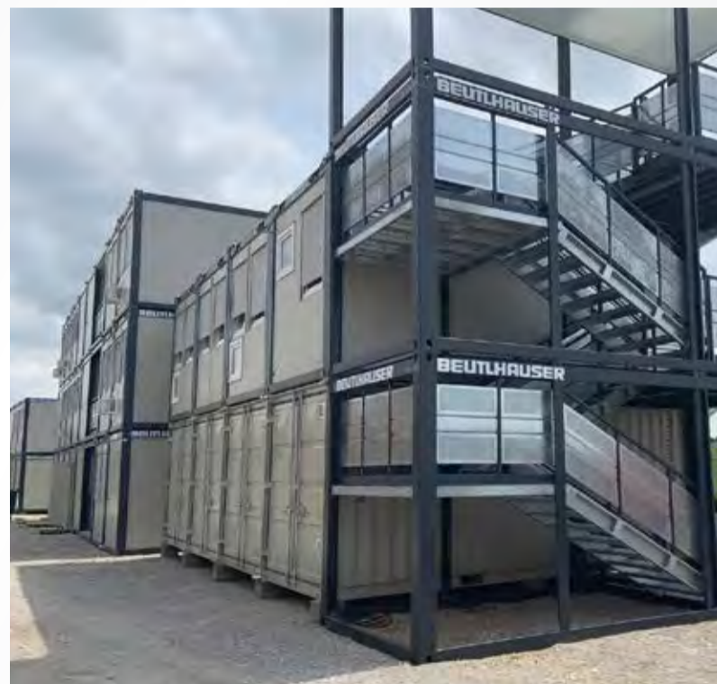
Gleich drei Containeranlagen wurden auf der Garchinger Baustelle von Beutlhauser realisiert. Alle drei erfüllen die Anforderungen des jeweiligen Kunden.
