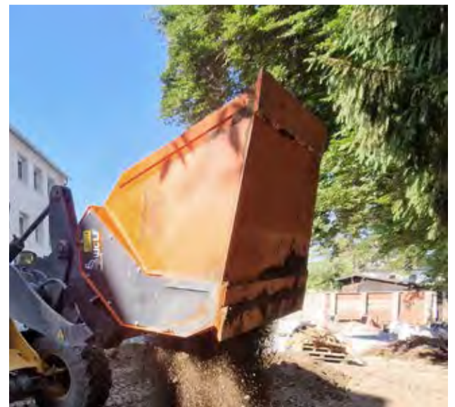
Seinen ersten Einsatz feierte der neue Separator auf einer Mehrfamilienhaus-Baustelle in Göggingen.
