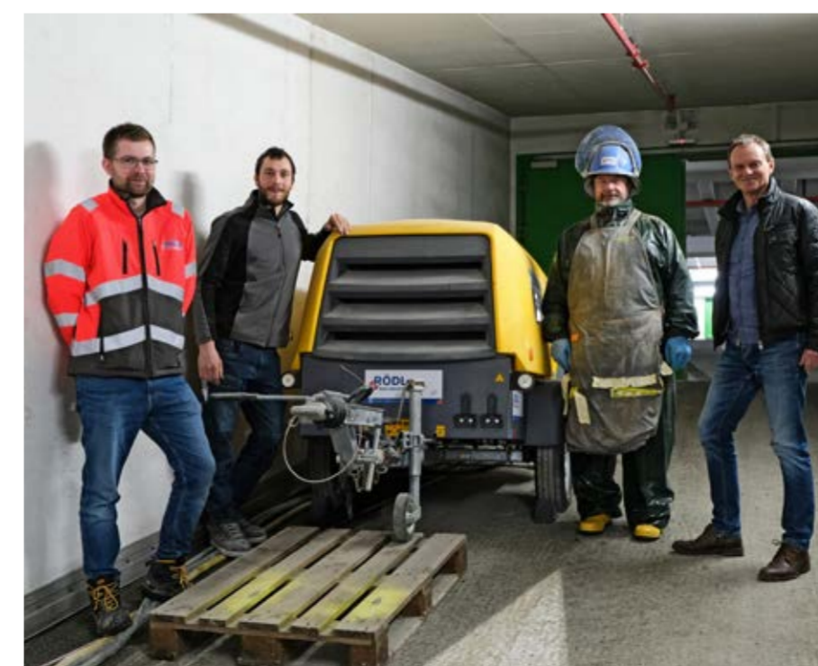
Für die Modernisierung des Wöhl-Parkhauses setzt die RÖDL BAU GRUPPE auf den VSD-Kompressor E-Air H250 von Atlas Copco. Das sei die beste Lösung für die Arbeit unter der Erde, sind sich (v. l.) Bauleiter Maximilian Winkler, Polier Silas Kramm, Mitarbeiter Günter Schmuderer und Beuthauser-Verkaufsberater im Außendienst Gerhard Kratzer einig.
