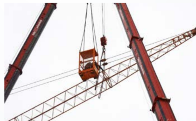
Aus einem Personenbeförderungskorb, der von den Autokranen gesichert wurde, arbeiteten die Monteure am Ausleger.
