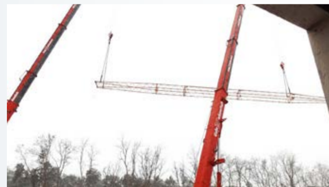
Die Ausleger wurden im „Tandemhub“ mit den Autokranen auf den Boden transportiert.
