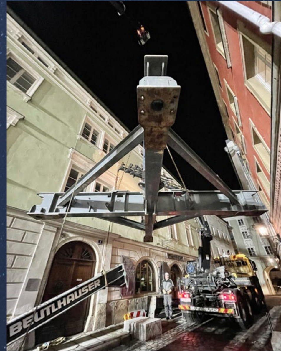
Der Ausleger des Autokrans stellte das Portal mit einem Abstand von nur wenigen Zentimetern zu den denkmalgeschützten Wohnhäusern auf.
